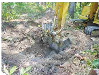
写真 17 エクスカベーターによる掘り取り
