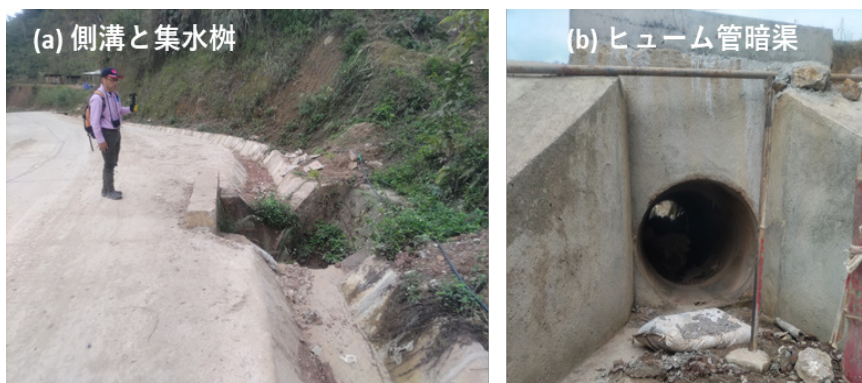
図 T06-2 側溝、集水柵、暗渠による基本的な排水システム
