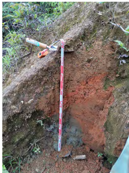
図 4-2-2-22 裸地化した道路下側斜面の土壌断面
