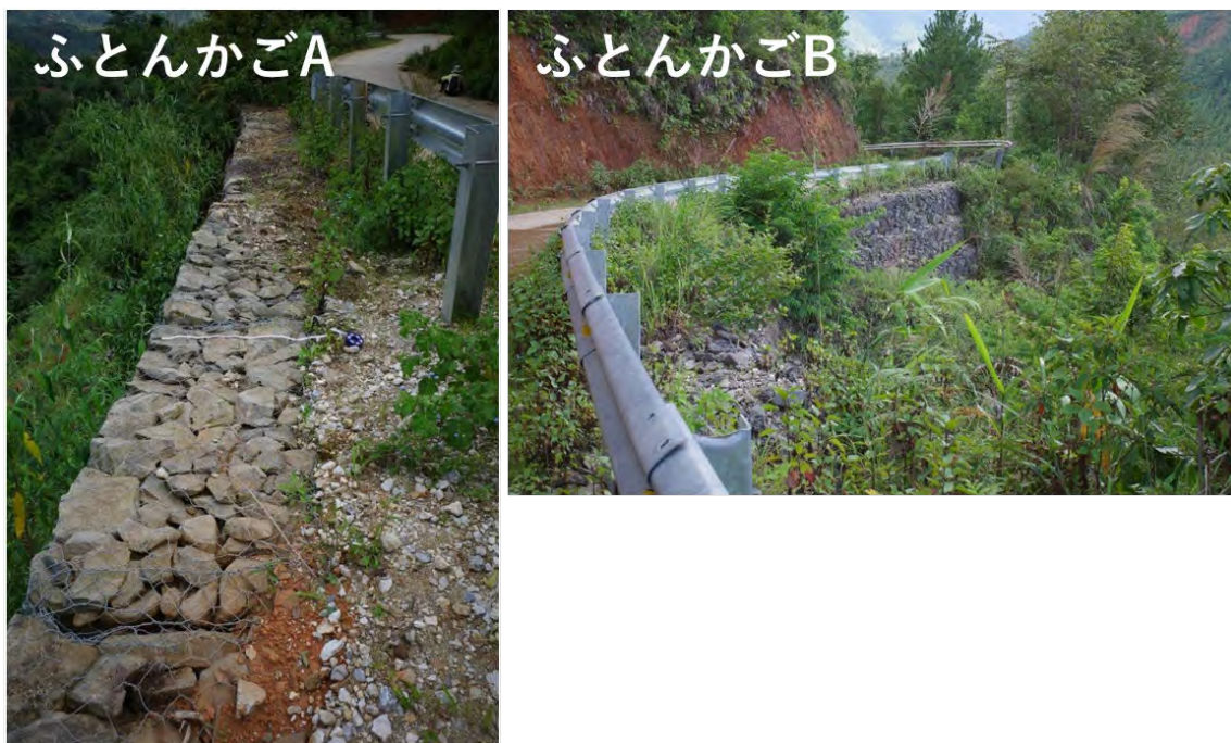
図 4-2-2-15 イエンバイ省ムーカンチャイの道路法肩部の斜面に建設されたふとんかご A(左)とふとんかご B(右)
