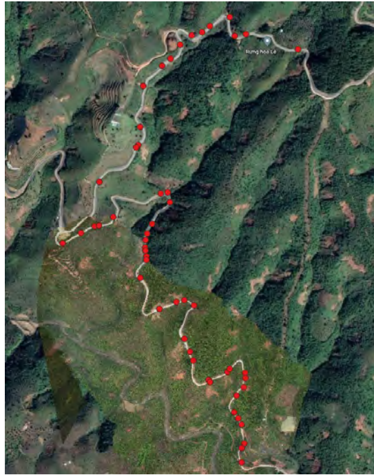
図 4-2-2-13a 調査対象区間で切取法面崩壊発生位置
