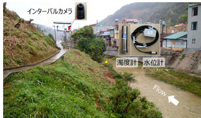
図 4-2-2-3 2022 年 9 月に設置した観測機材の位置(インターバルカメラはその後移設)
