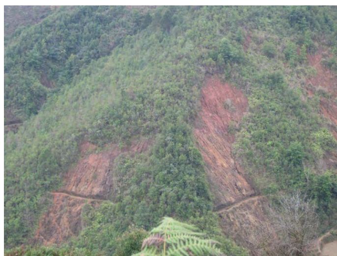
図 4-3-3-2 Mu Chang Chai District (Kim Noi Commune ほか) で現地調査の際に確認した崩壊 2023 年 2 月 26 日撮影
