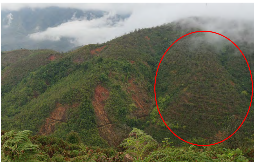
図 4-3-3-5 Mu Chang Chai District (KimNoi Commune ほか) の崩壊地および棚田跡 (写真赤枠の範囲)
