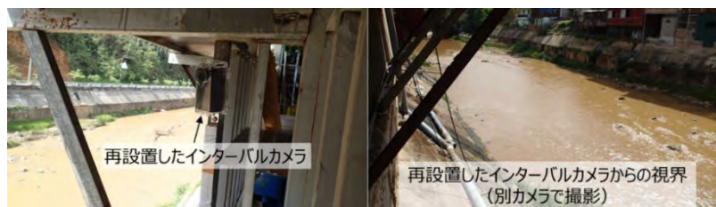
図 4-2-2-5 インターバルカメラの再設置工事(2023 年 2 月)
