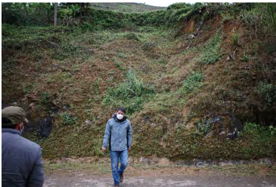
図 4-2-2-7 堆積岩(砂岩)分布域で発生した斜面崩壊③(ソンラ省モンゾンコミュニティ)
