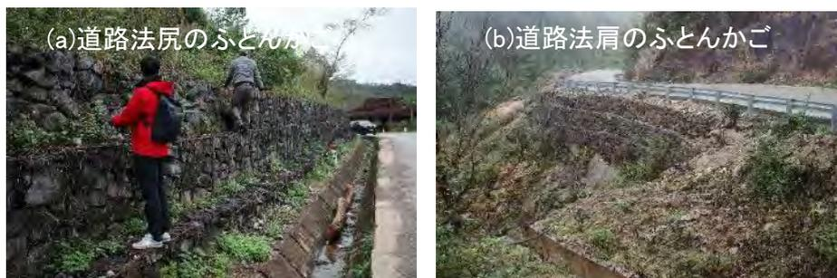
図 4-2-2-15 ふとんかごの施工例. (a)道路法尻部の設置. (b)道路法肩部の設置
