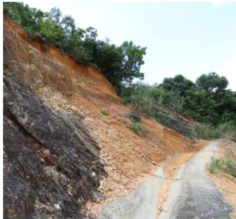
写真6.写真4の③地すべり性崩壊頂部
